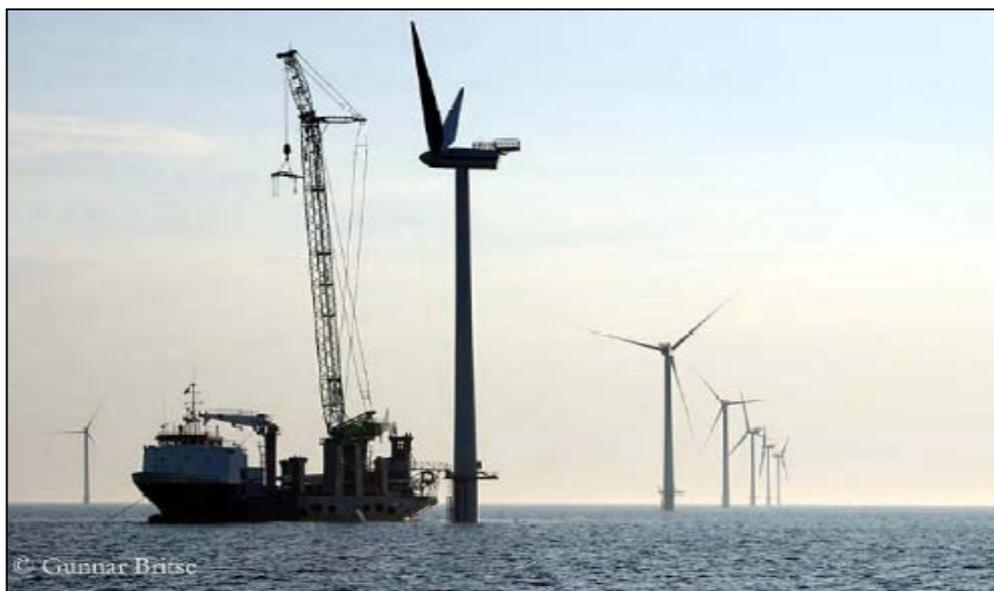
Figure (I-2) : Installation d'éoliennes offshore en Mer du Nord (Photo Gunnar Brilse)
