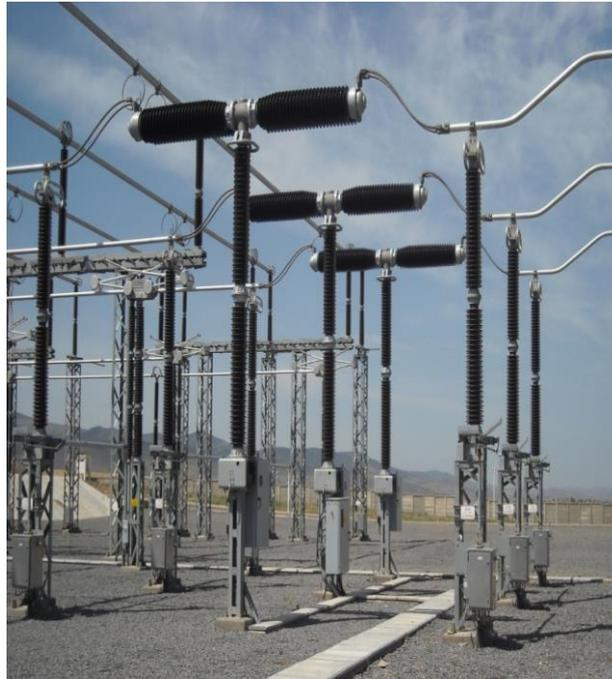
Figure 2.4. Disjoncteur SF<sub>6</sub> unipolaire 420 kV à deux chambres de coupure.
