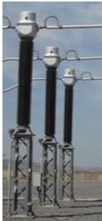
Figure 2.2. Transformateur de courant
