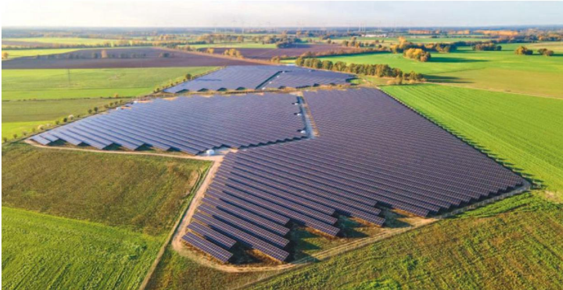
Figure 1.7. Une station de production PV de 21,1 MW en Allemagne.
