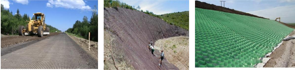
**Figure 1. 1:** Images illustratives du renforcement du sol par des géosynthétiques.
