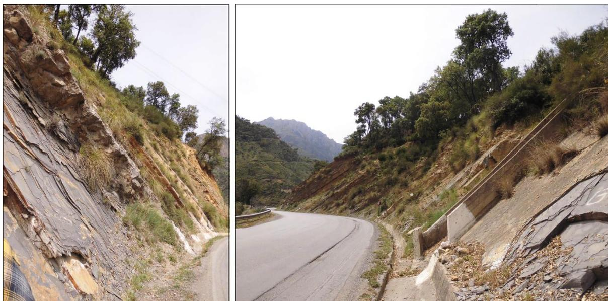
**Figure 7.14** : Présence limitée de fosse par endroits avec efficacité moyenne
