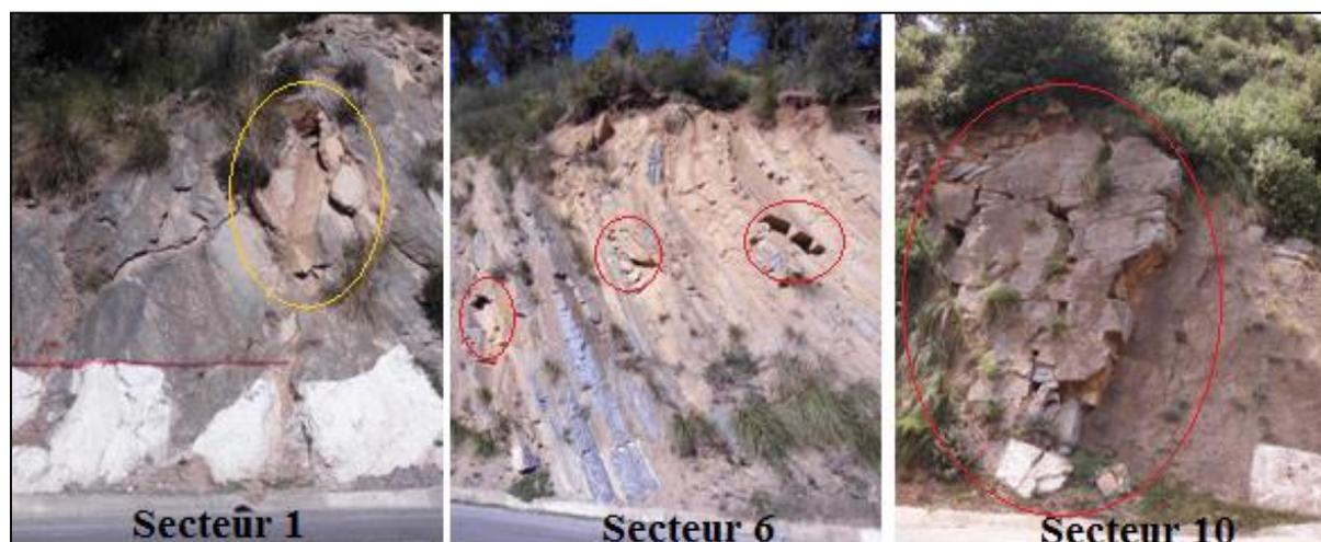
**Figure 6.19** : Trace des blocs détachés et blocs susceptibles à la rupture (talus Derguina)
