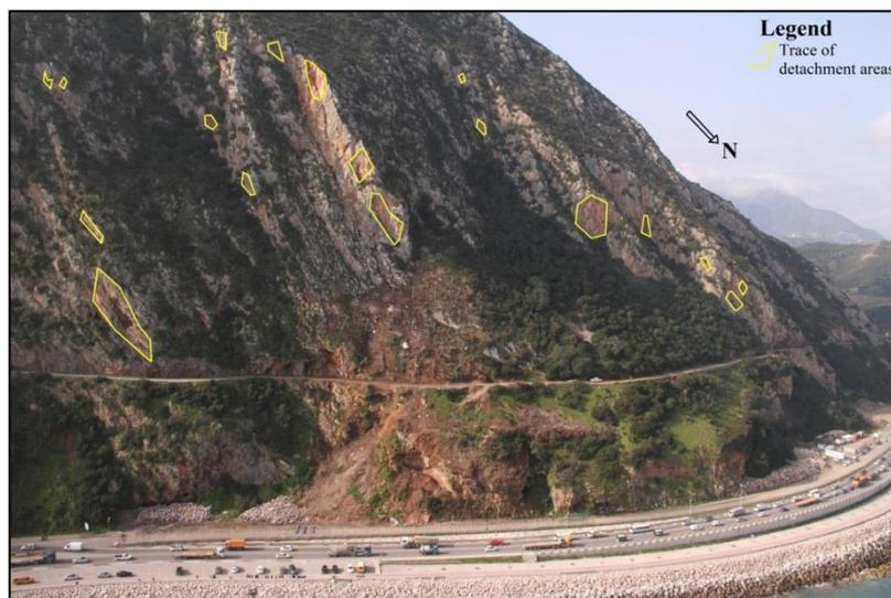
**Figure 6.7** : Répartition des zones sources des blocs à travers la falaise (DTP Béjaia 2016)
