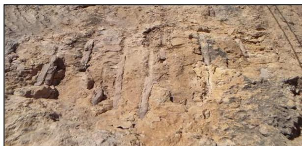
**Figure 4.23:** Traces des tirs de mine (BET CAN)
