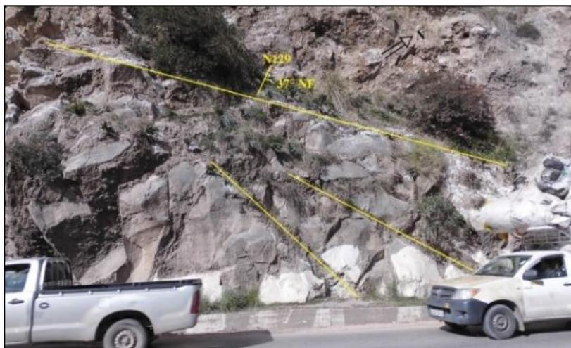
**Figure 4.25** : Plan de stratification des travertins
