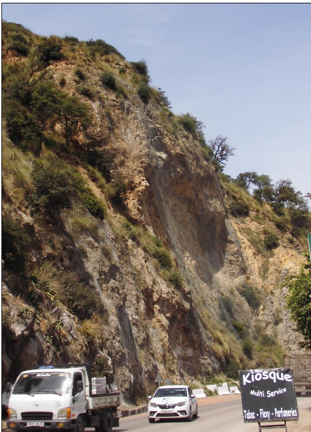
Figure 7.13 : Grillage pendu et grillage plaqué déposés au niveau du talus hôtel SAFSAF
