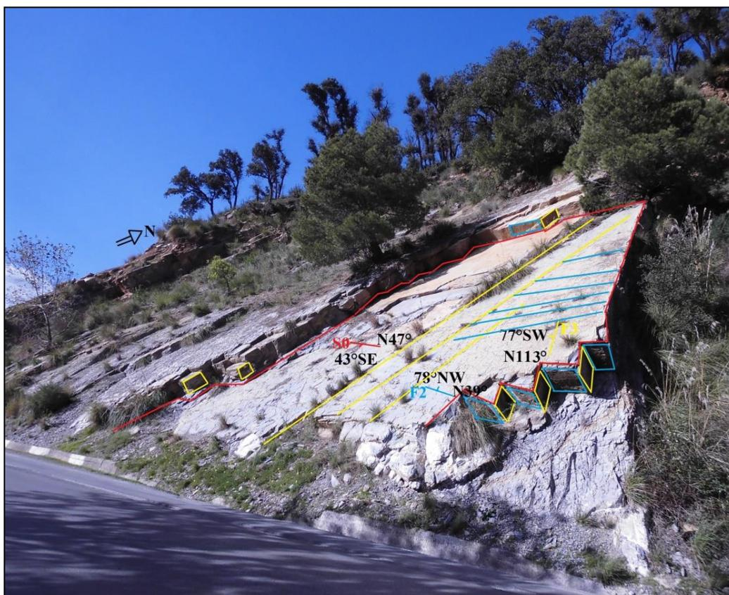
**Figure 4.35** : Plan de stratification et les deux familles F2 et F3
