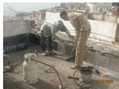
g) travaux d'étanchéification des terrasses
