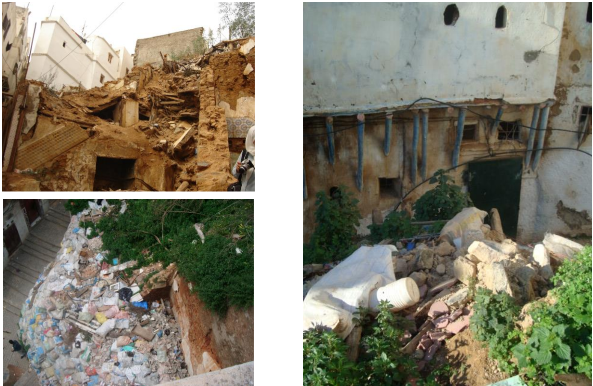
Figure 175 : État de quelques parcelles vides et de ruines devant faire l'objet d'une intervention – Photos de 2007 (Source : CEAT El Medina, 2022)
