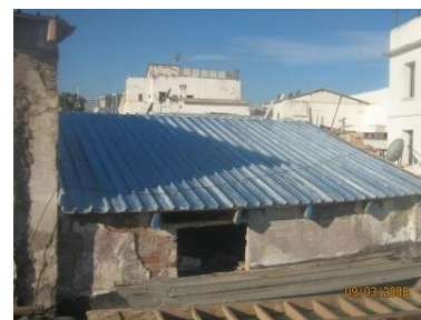
h) Couverture provisoire des terrasses avec de la TN40
