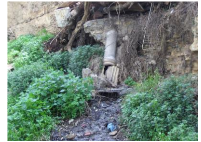
Évacuation des eaux usées à ciel ouvert – Quartier Amar El Kama – 2007 (Source : Groupement CNERU 2007)
