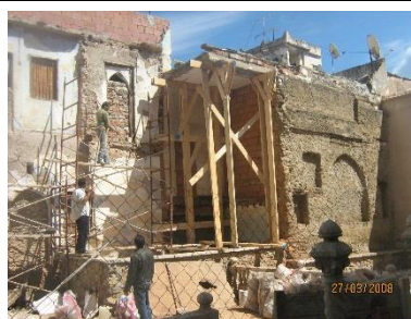
b) Étalement d'un plancher à partir d'un vide
