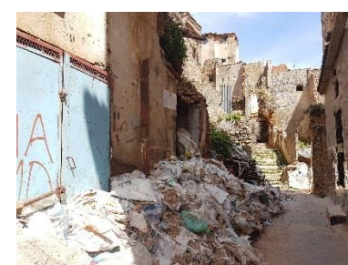
l) Évacuation des gravats à la DP
