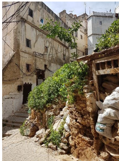
Angle des rues Kadi Said, Amokrane Mohamed et ali Lahmer Quartier Amar Ali (ex rue de la Casbah, source Auteure 2023)
