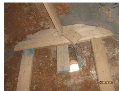
f) Étalement d'une voûte
