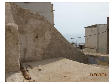
i) Étanchéification d'un vide après nettoyage
