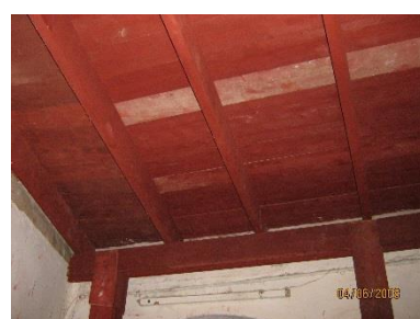
j) Réalisation de planchers provisoires
