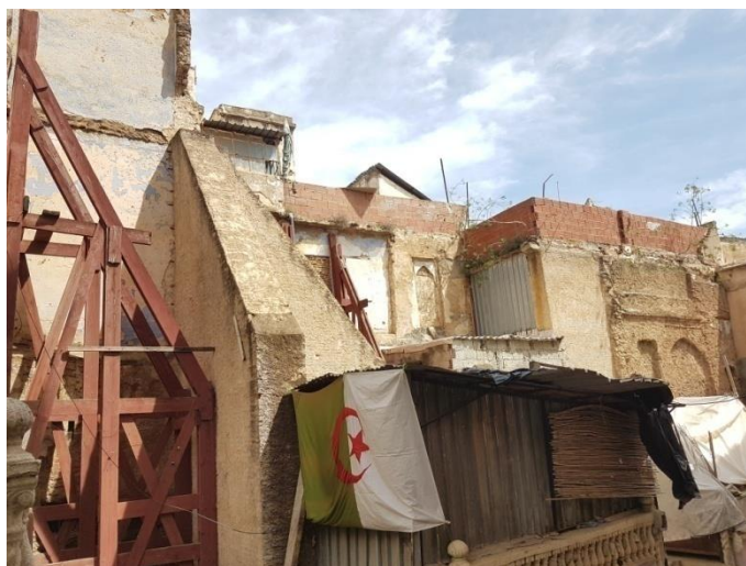
Vue sur le même vide de la rue Ali LAHMER – haute Casbah (Source : Auteure, 2008)
