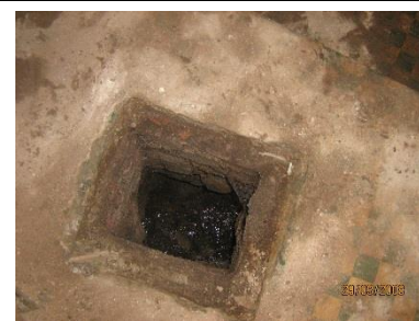
c) Ouverture d'un regard pour curage
