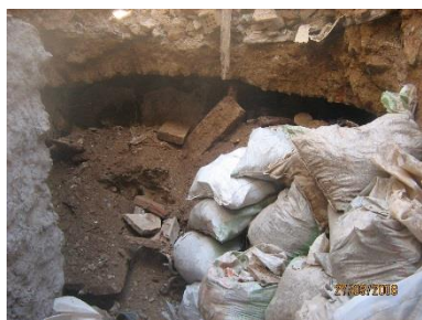
d) Mise en sac des gravats avant évacuation
