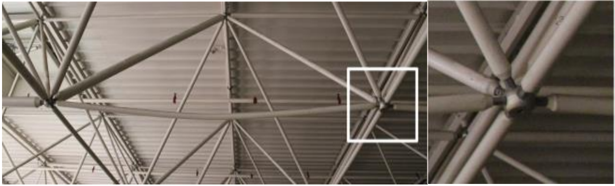
Fig.4.3 Nœud Mero typique indiquant l'absence de défaillance des boulons, des manchons et des sphères. (Adana)[93].
