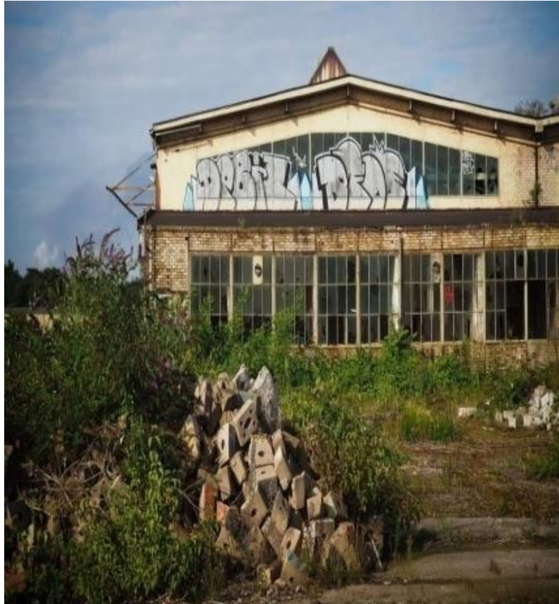
Figure 14 - Les espaces délaissés
