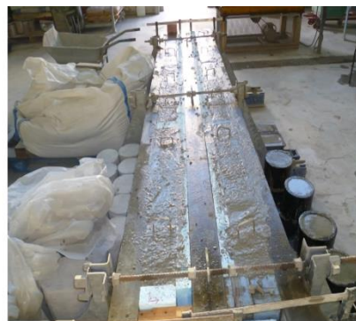
b) Concrete mixture pouring
