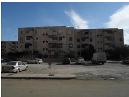
Photo. 10 : Voirie et parking
