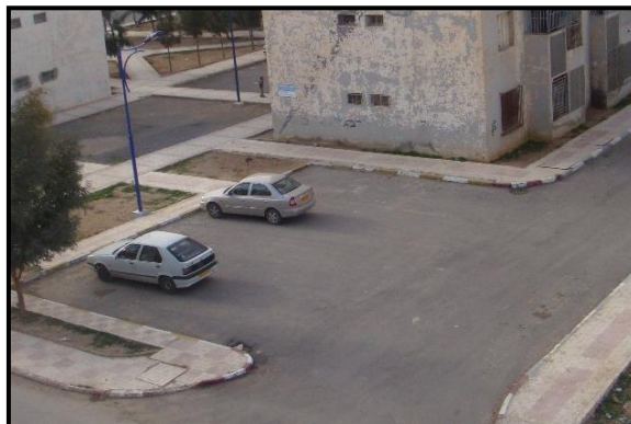
Photo. 3 : Aménagement adéquat de parking
