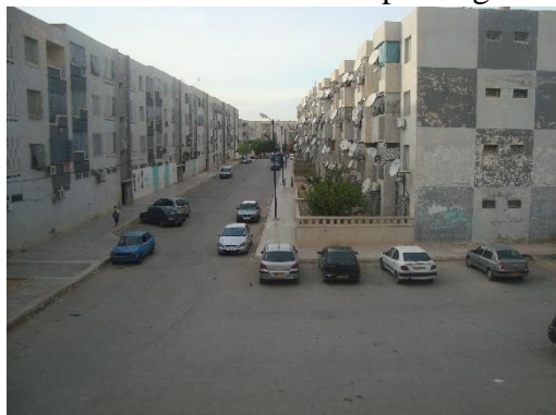
Photo. 7 : Voirie et parking
