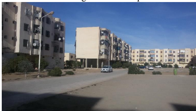
Photo. 25 : Aménagement de l'espace extérieur
