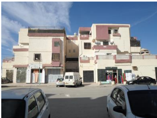
Photo. 40 : Voirie et trottoir
