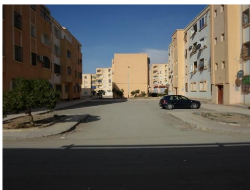
Photo. 24 : Voirie et parking
