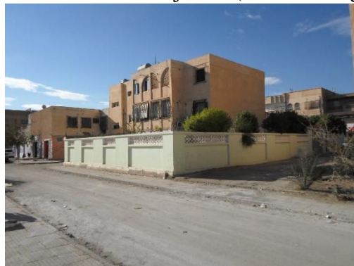
Photo. 47 : Réalisation de jardin (la cité 24 logements)
