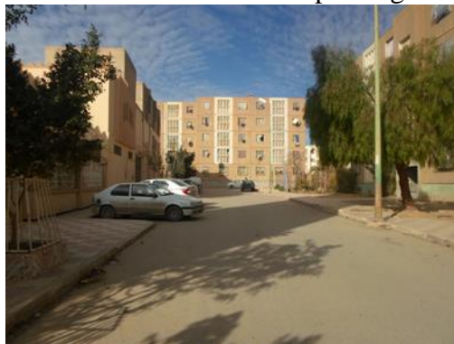
Photo. 2 : Voirie et parking
