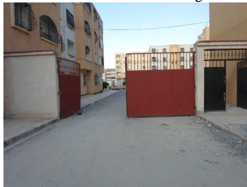
Photo. 44 : Portail de la cité 100 logements
