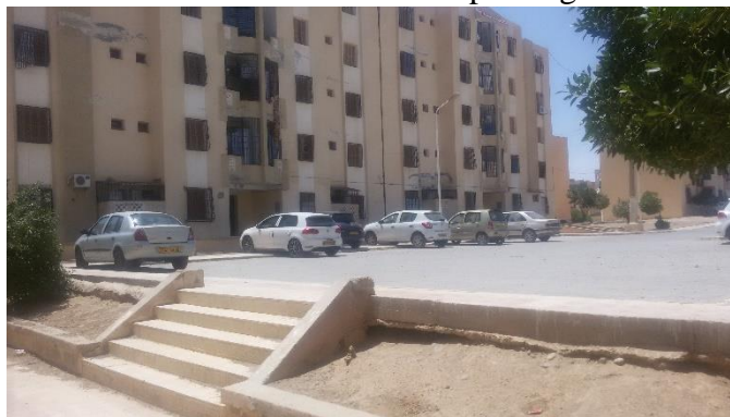
Photo. 30 : Voirie et parking
