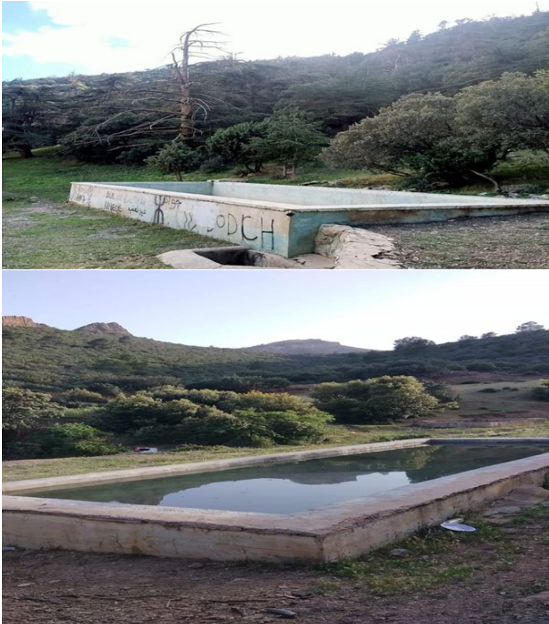
Figure 44: Bassin de retenue d'eau « Stockage ». (MARROUCHE,2022)
