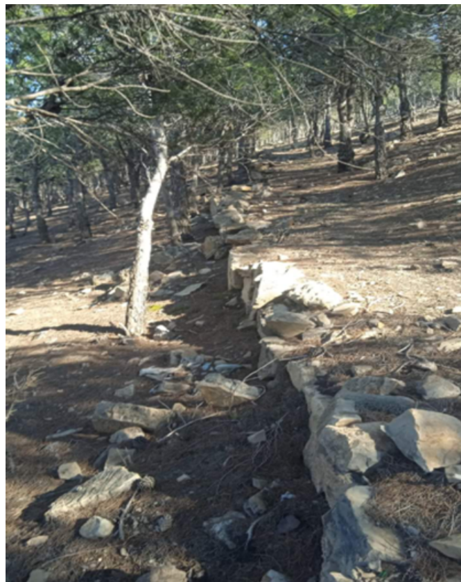
Figure 42: Action de la consolidation par « Banquette en pierres sèches ». (MARROUCHE, 2022)
