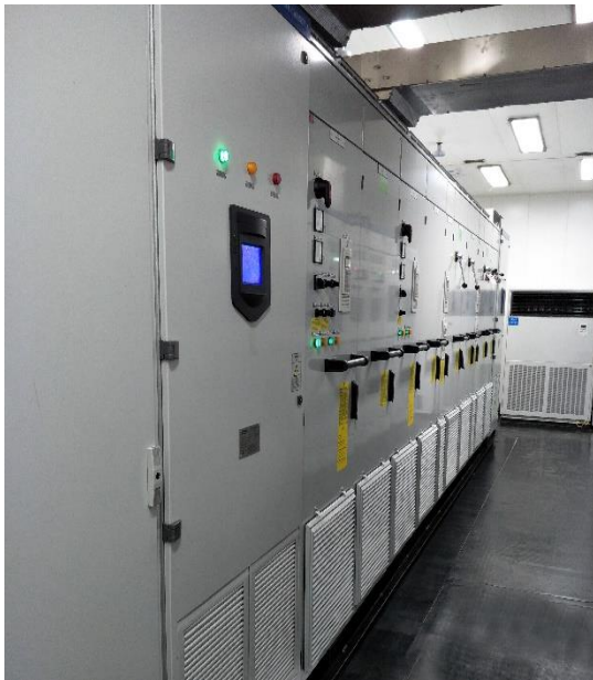
Figure I.10. FAP utilisé sur une plateforme de forage en mer.
