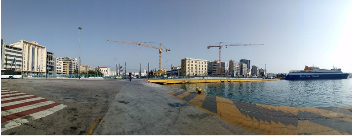
Figure 9. Une vue panoramique sur le port du Pirée en 2018. (Source : Amira Ghennai, 2018).
