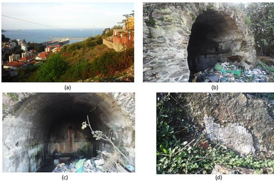
Figure 69. a La situation des citernes et de la citerne romaine près du port, b, c une partie des citernes, d la mosaïque qui est proche des citernes et sous le rempart colonial français.
