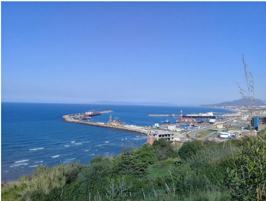
Figure 173. Une vue depuis Bouabaz sur le port El-djadid pour le pétrole et les hydrocarbures.
