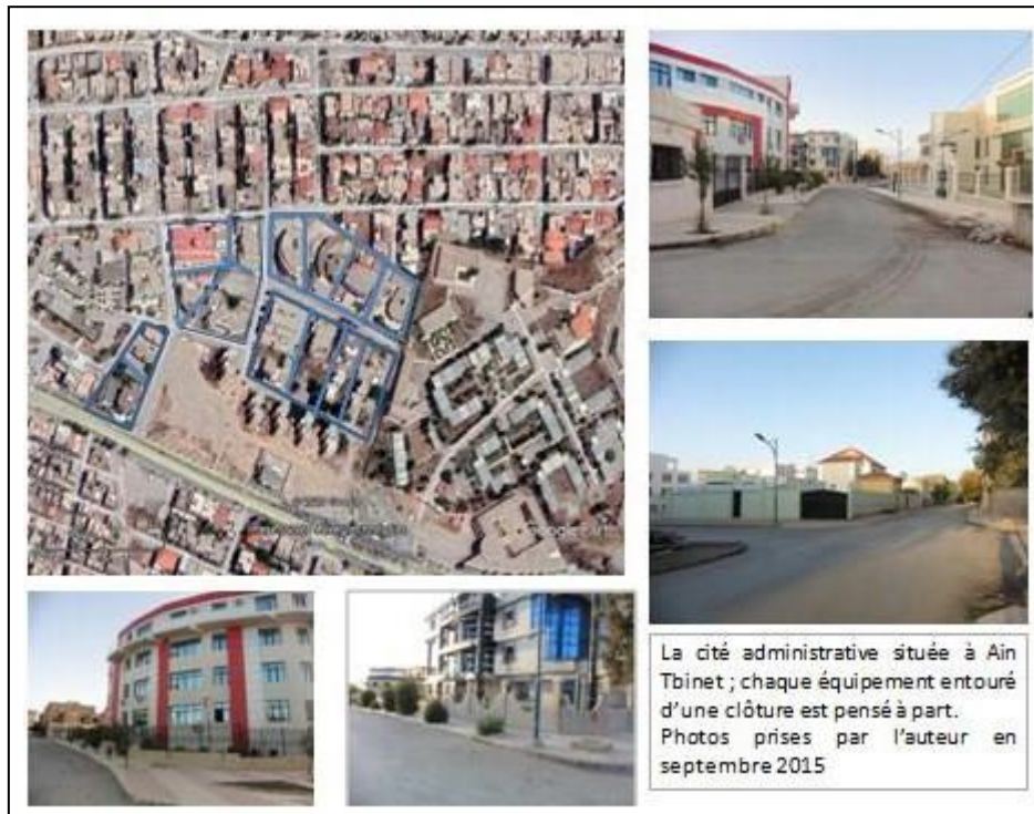
Figure 65 : la cité administrative de Ain Tbinet ; chaque équipement s'atomise dans son site. Source l'auteur photo aérienne : Google Earth
