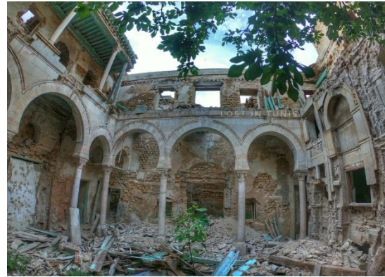
Figure 48: Wast ed-dar Dar el Hedri avant 117 et actuellement 118
