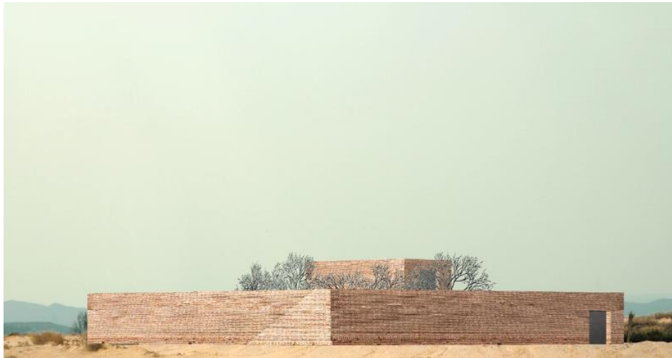
Figure 12 Façade extérieure du projet 25 rooms montrant le mur plein d'un seul étage d'office KGDVS
