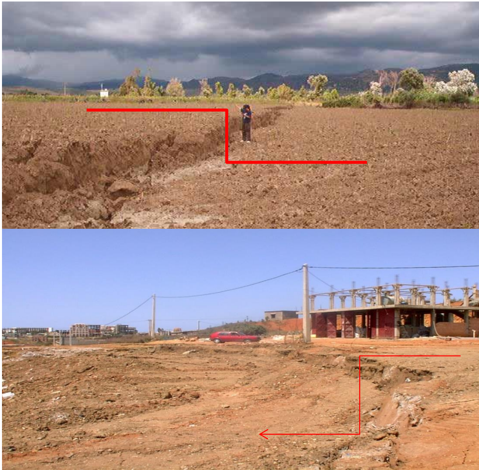
Figure 36: le jeu de faille observé sur le terrain (Sources : CGS et Rapport de la Protection civile, 2003)
