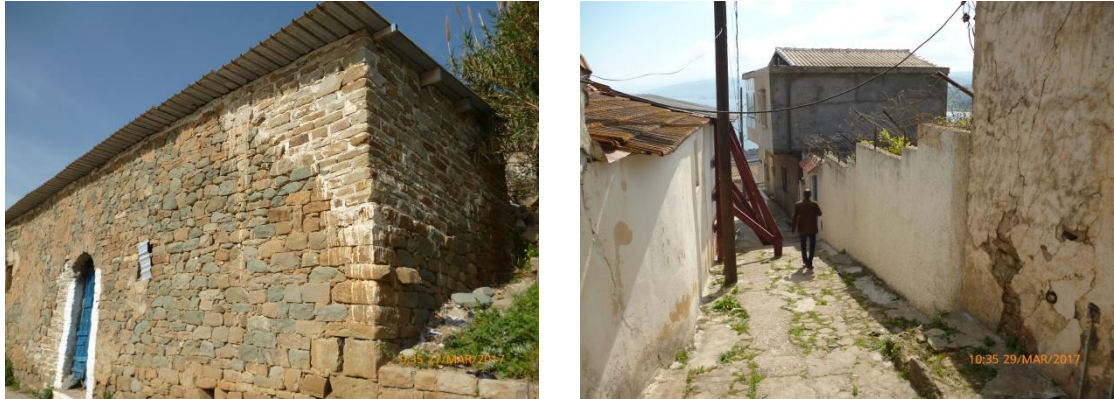
Figure 202 : Les étaielements et les tôles en zinc. (Source: Sehili,2022, 2017)
