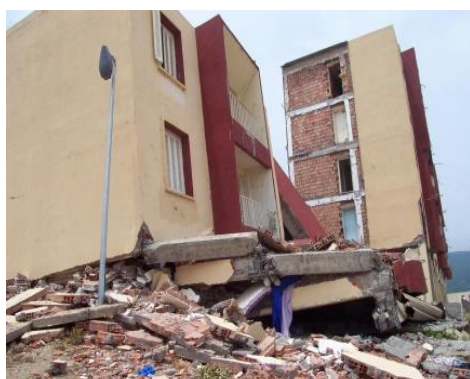
Figure 82: Les défauts de conception de l'immeuble en R+4. ( Source : AFPS 2003)
