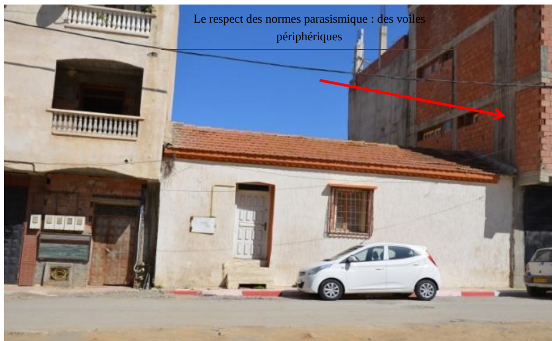
Figure 164: Le respect des normes parasismiques (voiles) dans une nouvelle bâtisse située dans le quartier européen. (Source : Sehili,2021)
