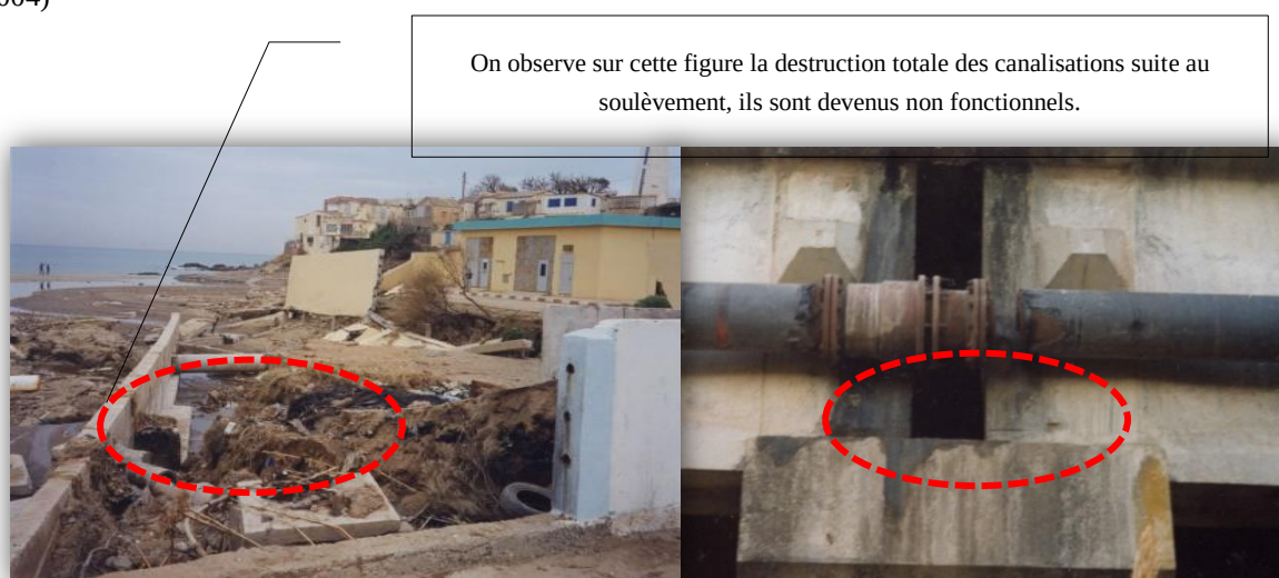
Figure 52: Les effets du séisme de 2003 sur les réseaux divers alimentation en eau potable et drainage des eaux pluviales ( AEP-DEP) (Source : Rapport Japan Association of Earthquake Engineering (JAEE) et al., 2004)
