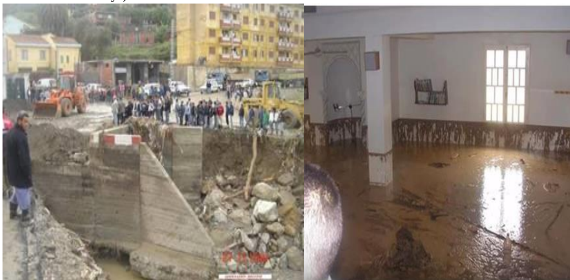
Figure 91: Endommagement des ponts et montée des eaux dans la mosquée après les inondations de 2007. (Source : APC de Dellys)
