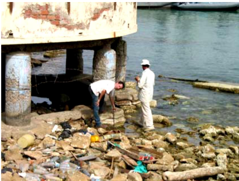
Figure 87: Niveau de l'eau de mer après le soulèvement de la côte au port de pêche de Dellys. ( Source : Bechtoula 2003)
