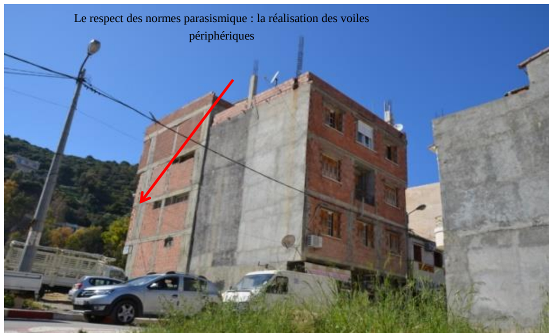
Figure 163: Le respect des normes parasismiques dans une nouvelle bâtisse située dans le quartier européen. (Source : Sehili,2021)
