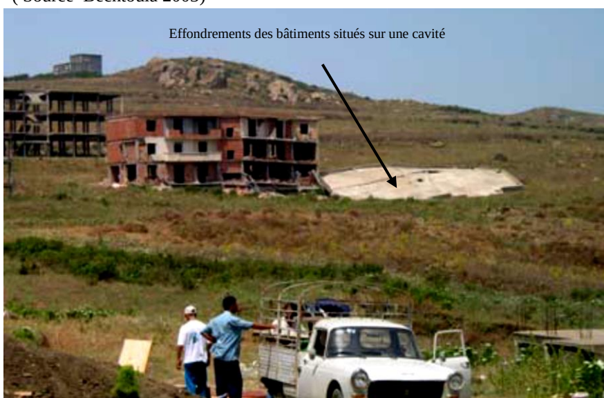
Figure 89: Endommagement des bâtiments situés sur des cavités en pente entourées de collines rocheuses. ( Source Bechtoula 2003)
