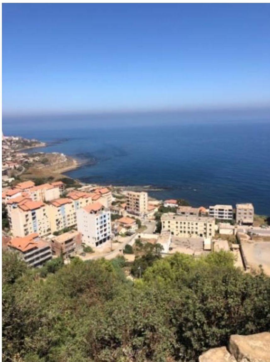
Figure 207: Le quartier Sikha, « site glissant », (Source : Sehili, 2022)
