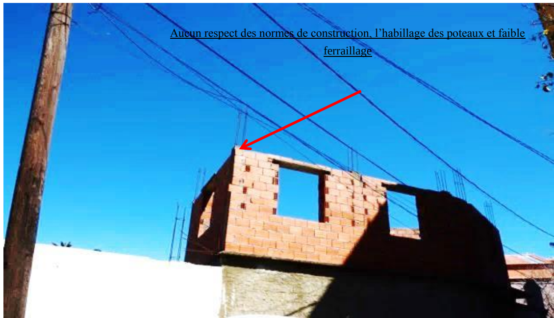
Figure 162: Le non-respect des normes parasismiques : ferrailage des poteaux d'une nouvelle bâtisse, située dans le quartier européen. (Source : Sehili,2021)
