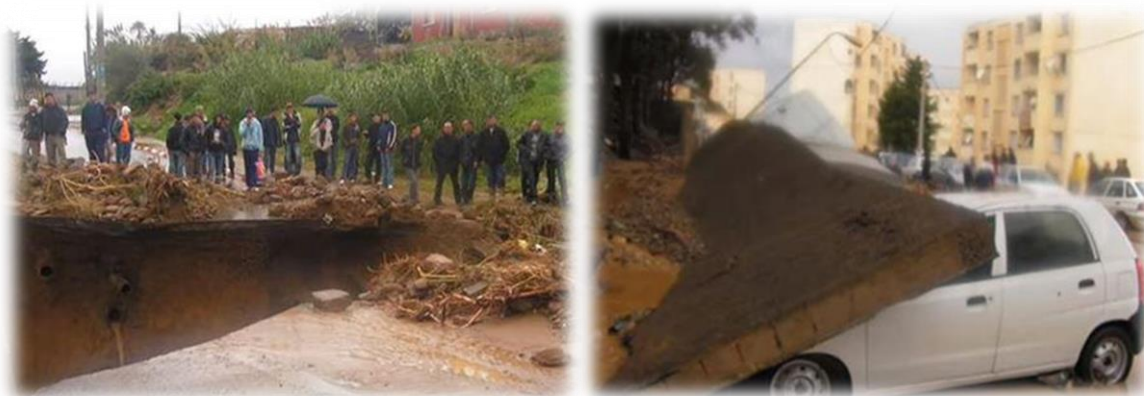
Figure 3: dommages de l'inondation de 2007 à Dellys ( source : assemblée populaire communale (APC) Dellys, 2017)
