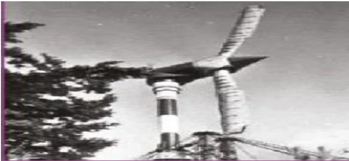
Fig.1.8. Eolienne installée en Algérie (Grand Vent) en 1957 [17].
