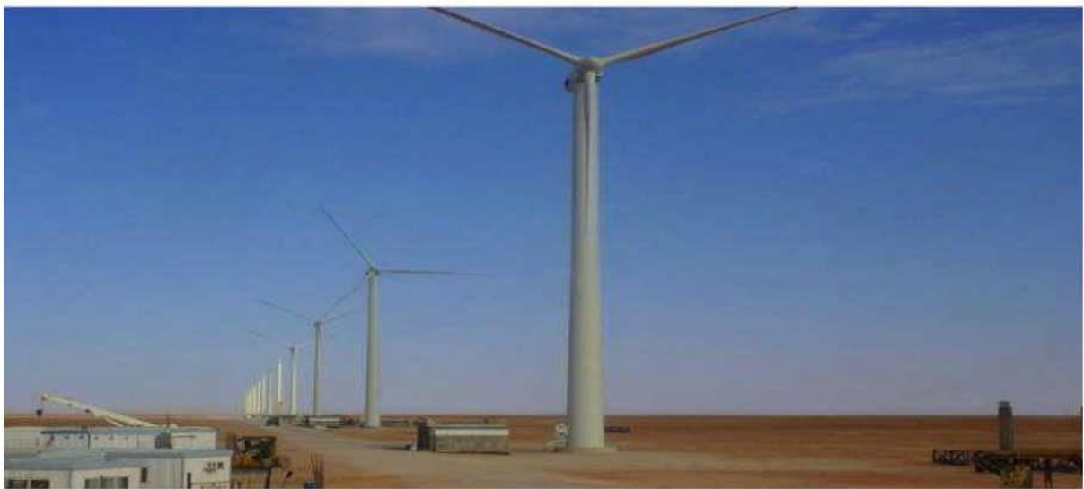
Fig.1.10. La 1ère ferme éolienne de 10MW à Kabertène (Adrar) [18].
