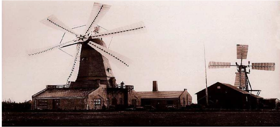
Fig.1.1. Première aérogénératrice de Poul La Cour en 1891 à Askov, Danemark [14].
