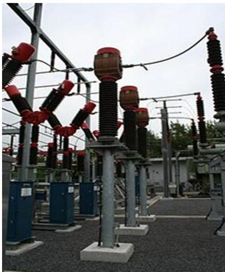
**Figure 1.7 :** Photo du transformateur de courant sur site d'exploitation
