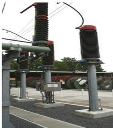
**Figure 1.5** : Photo d'un transformateur de tension (potentiel) sur site d'exploitation [26]
