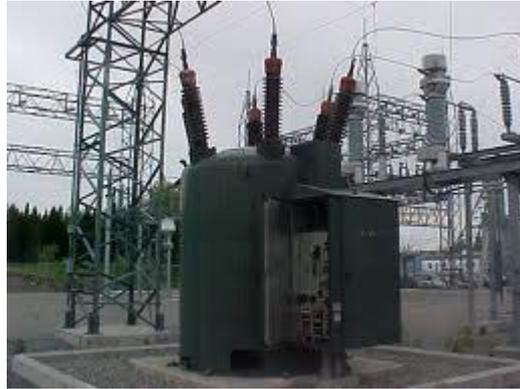
**Figure 1.10** : Photo d'un autotransformateur sur site d'exploitation
