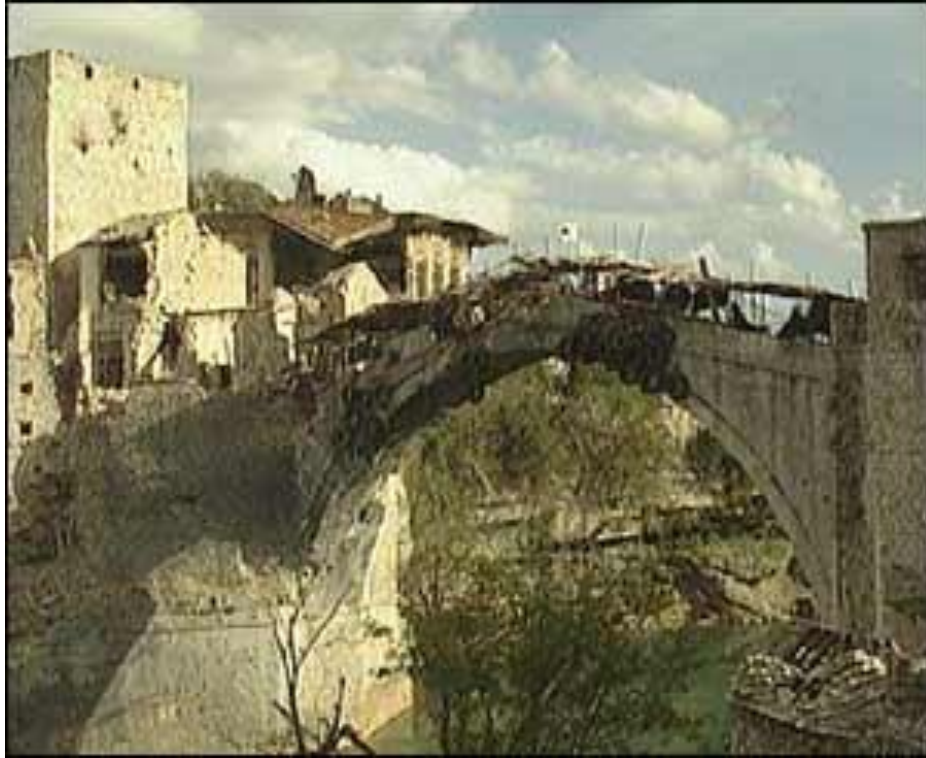
Figure 1.3. Destruction du pont ottoman de Mostar Pendant la guerre de Bosnie-Herzégovine, en 1993. Source : Google image.
