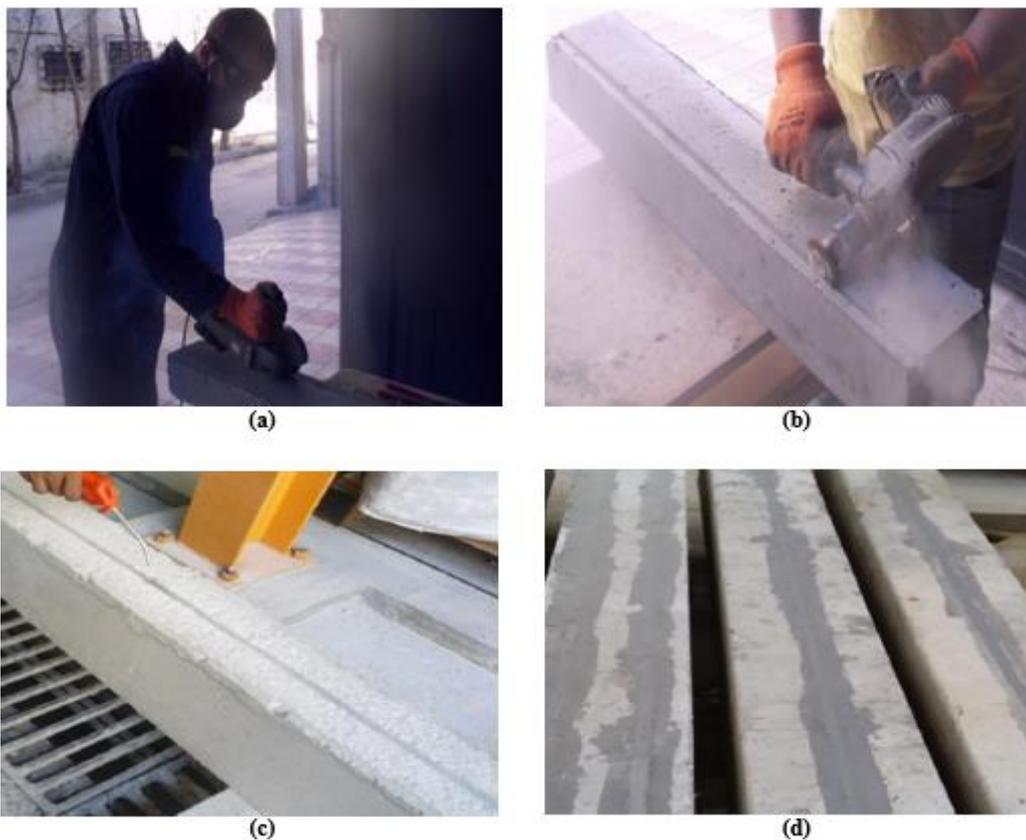
**Figure IV. 3:** Procédure de fabrication et renforcement des poutres, a) création des engravures, b) traitement de surfaces des engravures, c) Nettoyage avec l'air comprimé, d) scellement des renforts.
