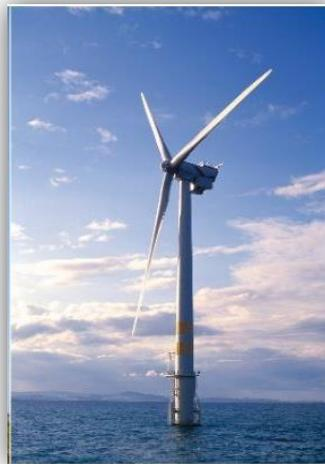
Figure 3.2 Eolienne à axe horizontal
