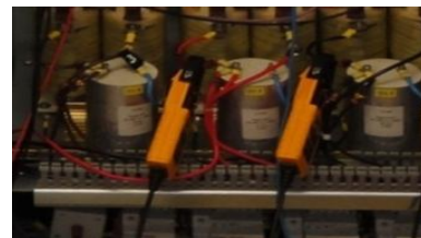
(d). Capteurs de courants (pinces Ampéremétriques).
