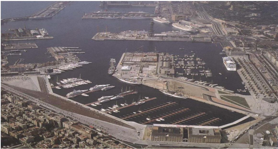
Figure 78: Photo sur la partie portuaire en cours de réalisation des travaux en 1991. / Source : (Rolando, 2004).
