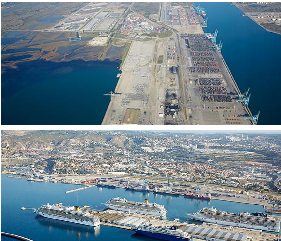
Figure 24: De haut en bas ; 1/ Ancien port de Marseille versus 2/ le Nouveau grand port de Fos à titre comparatif de point de vue taille, ce dernier est censé remplacer progressivement le vieux port de Marseille depuis 1968 / Source : (MarseilleFos, 2018).
