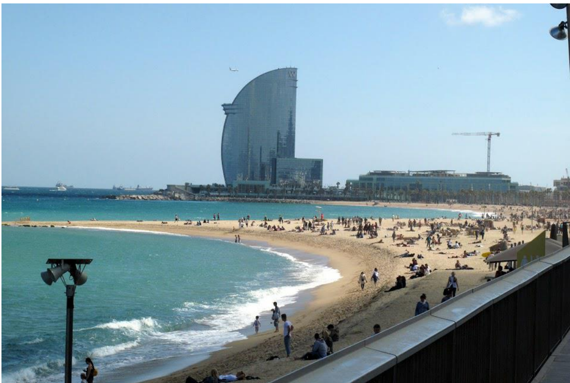
Figure 79: Hôtel W Barcelone, réalisé en 2009, œuvre de l'architecte international Ricardo BOFILL réalisé sur le vieux port, symbole de réussite économique de la ville. / Source : Auteur, 2018.
