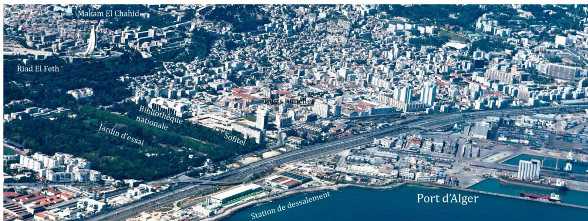
Figure 73: Vue générale sur la quatrième séquence et sa composition urbaine avec indication des repères et infrastructures importants. / Source : Photo prise d'avion de source inconnue, modification par l'auteur.
