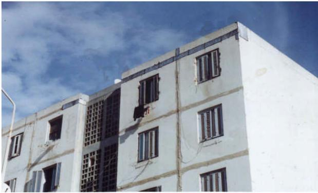
**Figure N° 39 : Joints de façade détériorés (l'auteur).**
