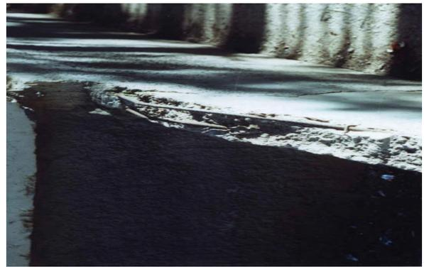
**Figure N° 40 : Soubassement en B.A dénudé (l'auteur).**
