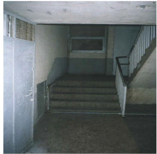
**Figure N° 43 : cage d'escalier dépourvue d'éclairage (l'auteur).**
