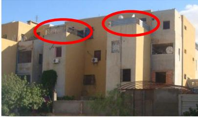
**Photo. 26 : Création d'un balcon avec garde du corps en dur**
