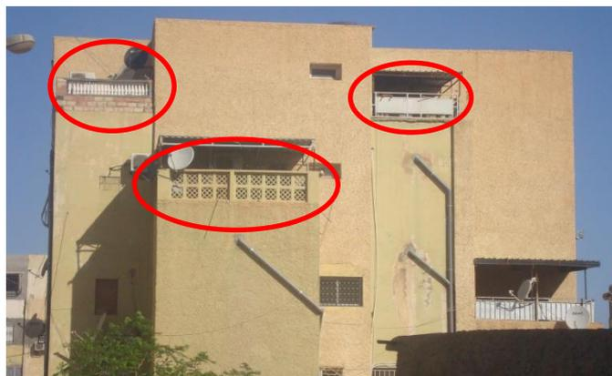
Type 06 : 07 ménages ont construit totalement les trois murs à hauteur de l'étage du nouveau balcon créé sur la dalle du logement de l'étage inférieur et puis couvrir le nouvel espace par des tôles pour que ce dernier soit le prolongement de la chambre initiale.
