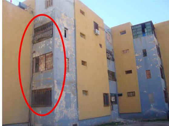
Type 05 : 06 logements ont opté pour l'ouverture d'une porte de 1m pour communiquer avec le nouveau balcon (ou nouvelle terrasse) créé sur la dalle du logement de l'étage inférieur, en surélevant son acrotère, comme garde du corps, par un muret en dur ou carrément en utilisant du bardage métallique.
