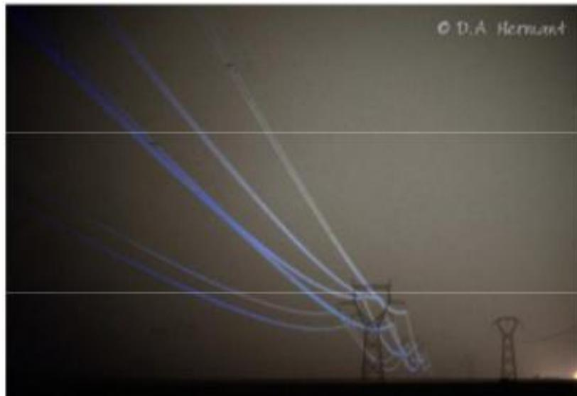
**Figure 2.1** Effet couronne sur les lignes de transmission.
