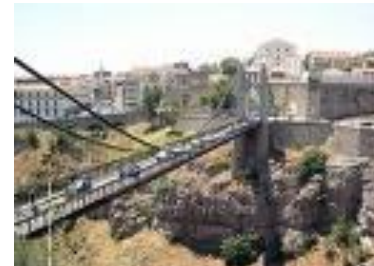
Figure 41 : Pont de Sidi M'cid, Constantine
