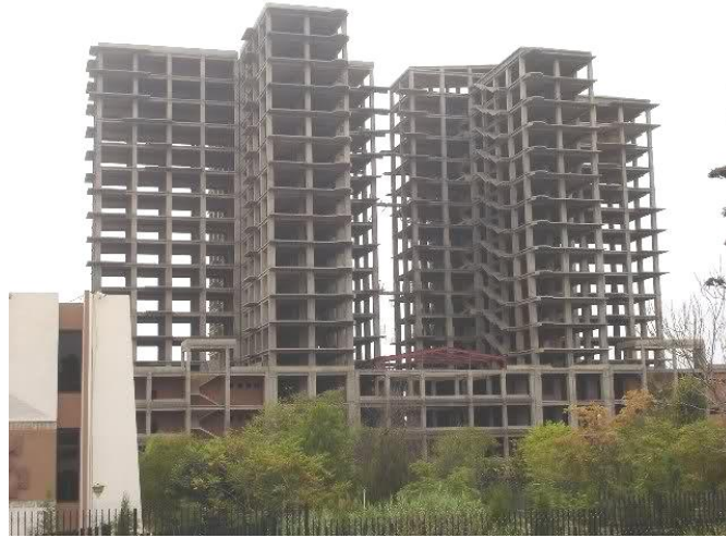
Figure 5 : Ossature du projet El Ali.
