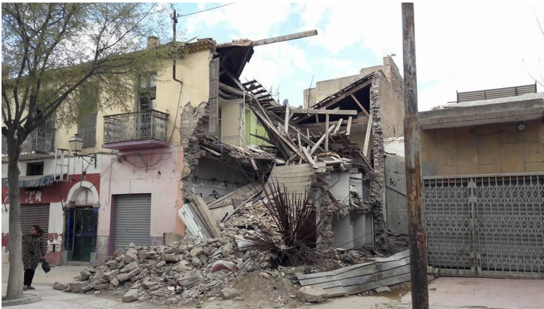
Figure 11 : Dépérissement du patrimoine immobilier colonial du centre ancien à Sétif.
