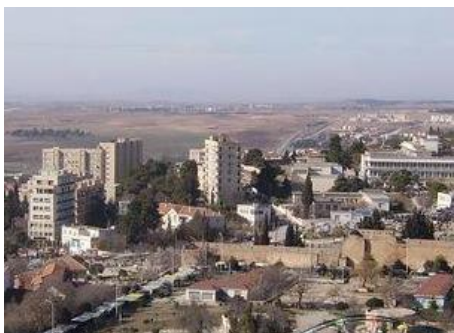
Figure 49 : Ex-marché informel à l'intérieur d'un site historique à Sétif.
