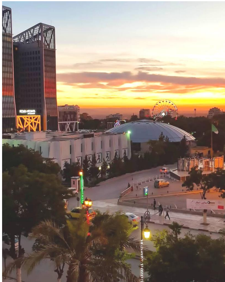
Figure 62 : Hôtel Sheraton : Dome et Business Centre, le Park Mall, Sétif, 2018.
