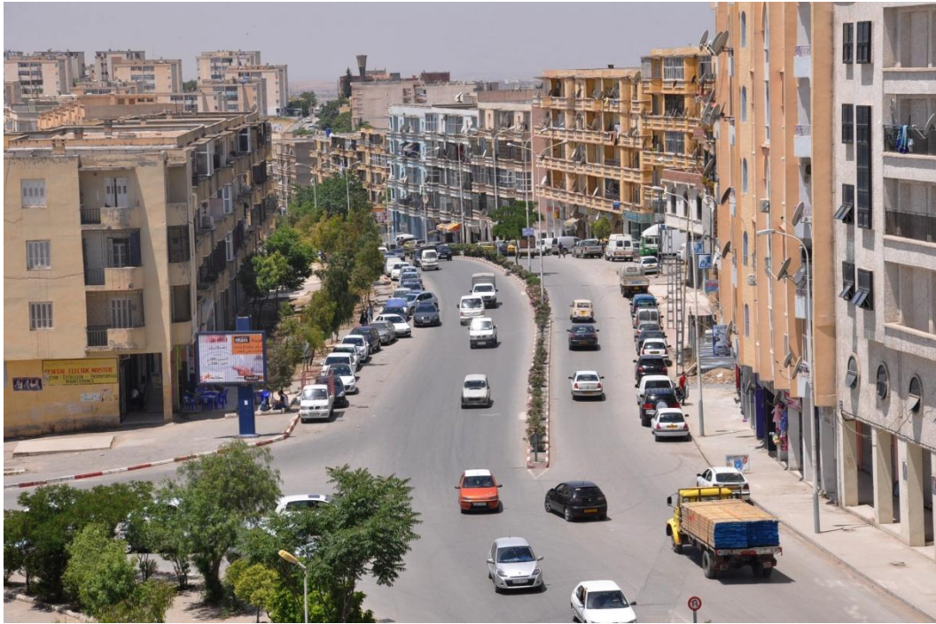
Figure 57 : Boulevard des Entrepreneurs, 1 ère tranche T1, direction vers Bel Air, 2012.
