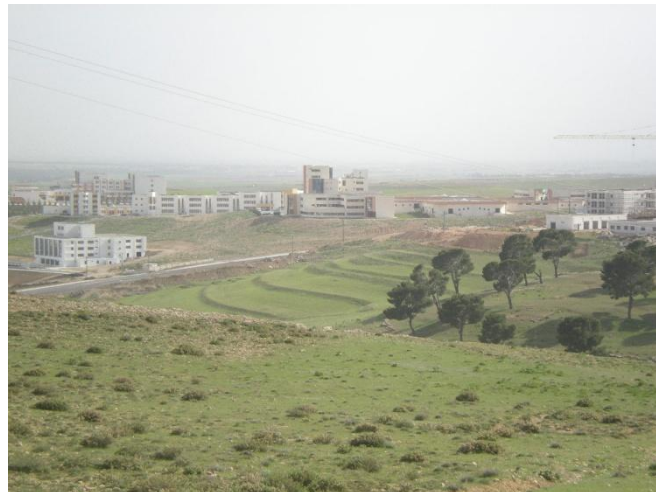
Figure 7 : Campus El Bez en construction, année 2007.
