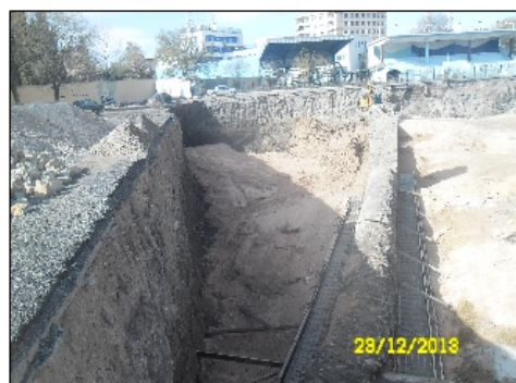
Figure 2. le canal qui traverse le sud du stade. et la couche de remblais d'une épaisseur importante
