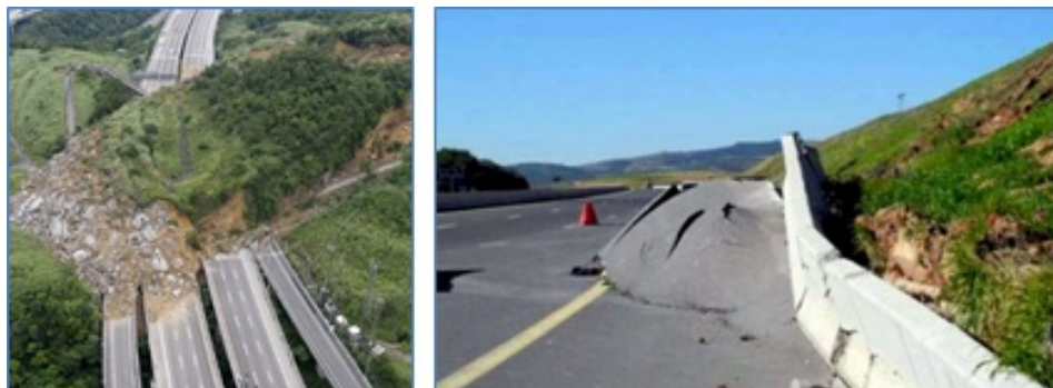
Figure 01. a. Glissement de terrain sur une zone autoroutière à Taiwan (source : https://blogs.agu.org/landslideblog/files/2010/10/10_04-Highway-4.jpg ). b. Glissement au niveau de l'autoroute est-ouest dans la région de Tlemcen (source : http://www.leconews.com/images/2015/04/04/large-11288_854604_679x417.jpg ).
