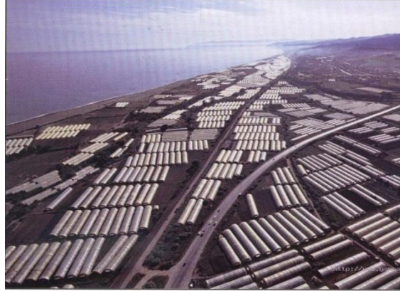
Vue aérienne serres
