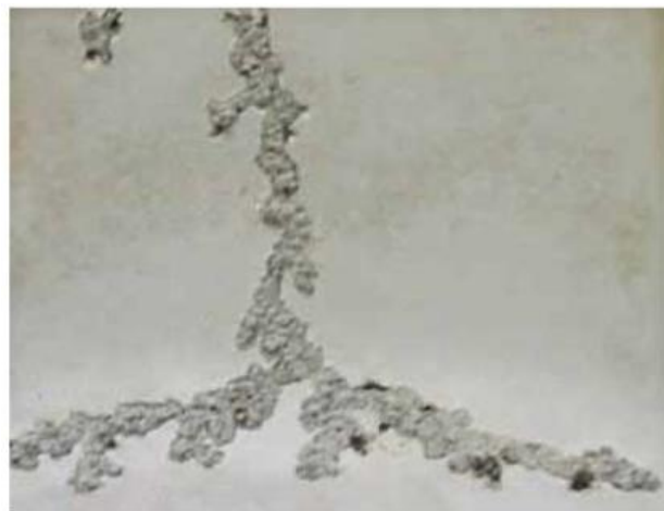
Figure 3.8 : Trace de dégradation sur la surface de l'isolateur polymère [3.52]
