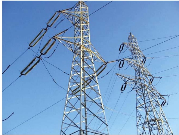
Figure 2.3 : Isolateurs composites sur une ligne électrique
