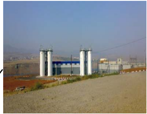
Photo VI.2: Méga station de pompage
