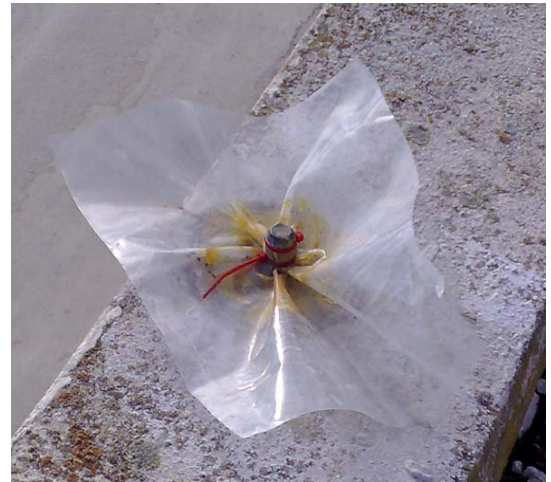
Photos IV.7 : Boulon monumenté
