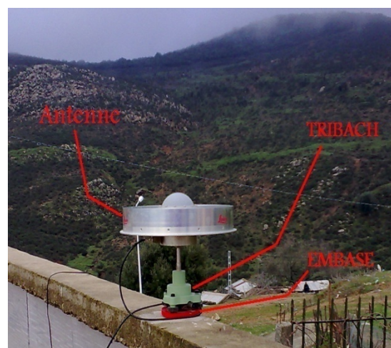
Photos VI.9 : Antenne LEIAT504, site OHBA.
