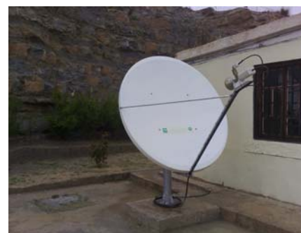
Photo V.7: Transmission par satellite (VSAT) des données de la station vers le Datacenter (Alger).
