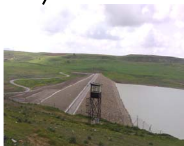
Photo VI.4 : barrage de Oued Athmania
