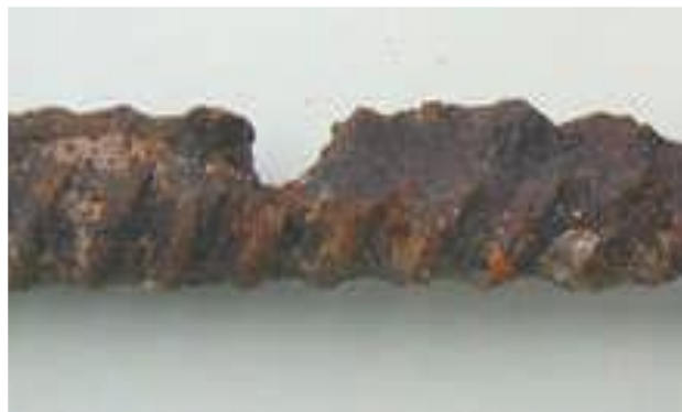
Figure I.14 : Piqûres de corrosion dues aux chlorures.
