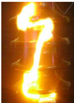
Fig. 2.1 Arc électrique à la surface d'un isolateur.
