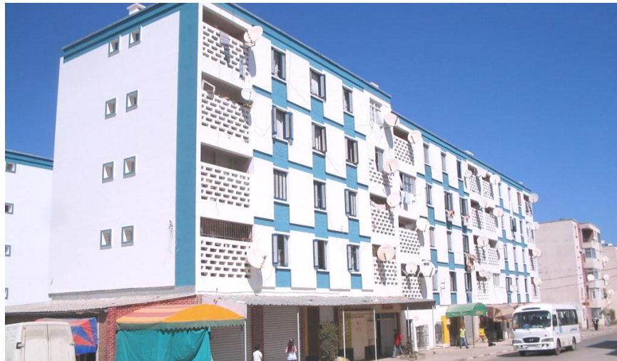
Figure 17: Exemple de réhabilitation du cadre bâti (après),
