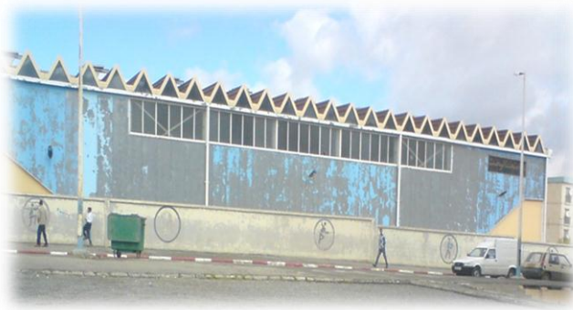
Figure 51: La salle de sport, source : auteur, 2009.
