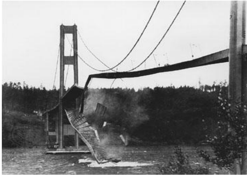
Figure I. 6 : Pont de Tacoma Narrows au moment de l'effondrement sous l'effet du vent.
