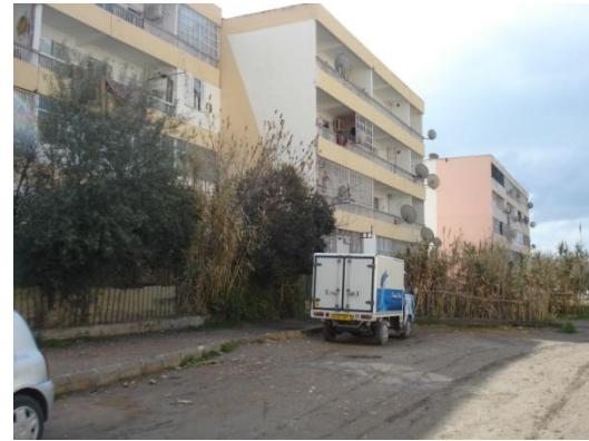
Photo 4.15 Espace limitrophe au logement
