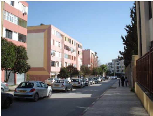
Photo 4.6 La voie secondaire Est
