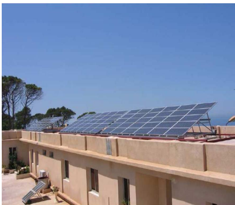
Figure A.2. Installation du générateur photovoltaïque sur le toit de CDER.
