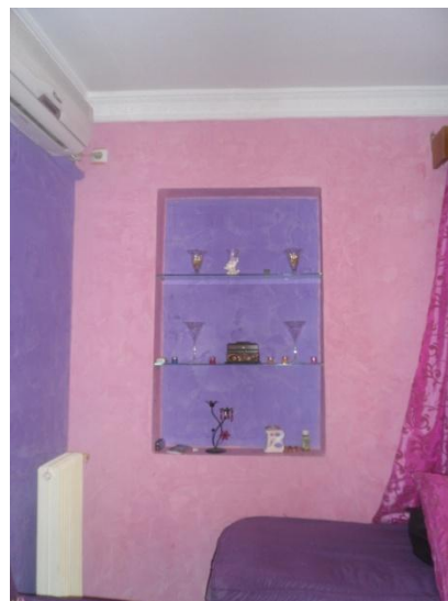
Photo 19: Remplacement de l'ouverture par une niche
