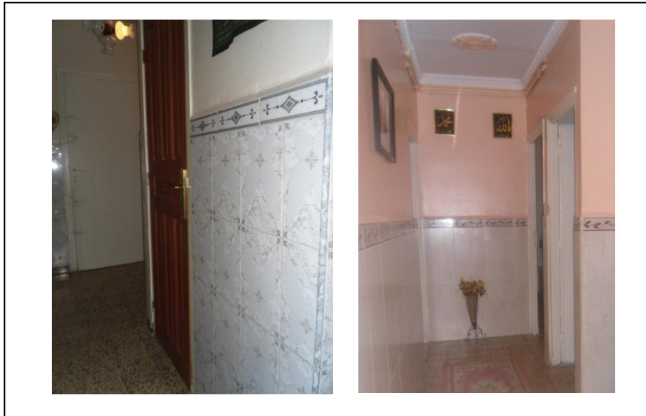
Photo 23 : Travaux de plâtre, de peinture et faïence à mi-hauteur
