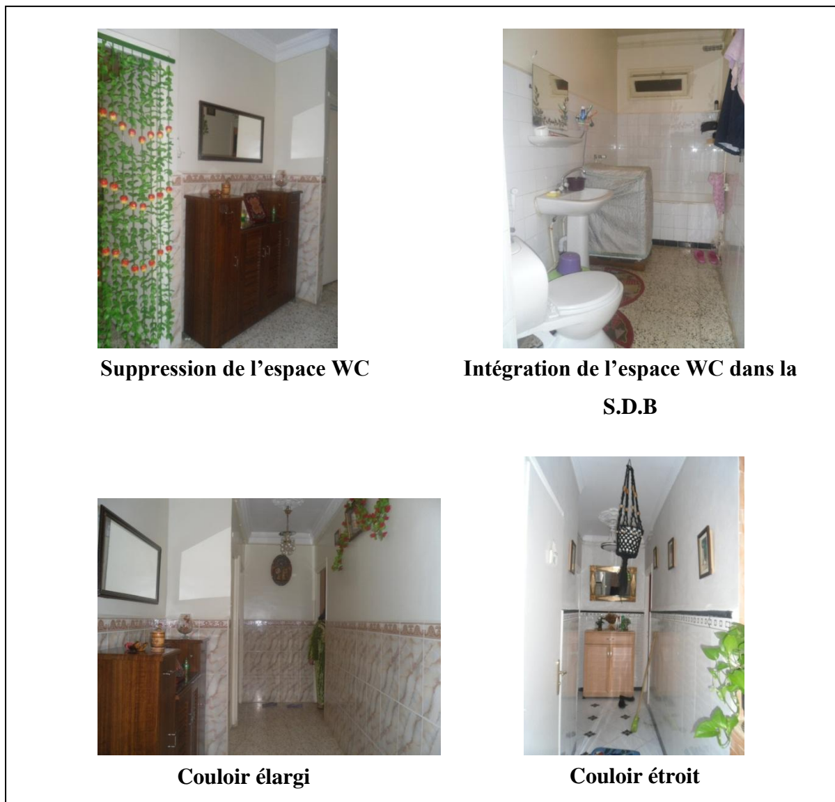
Photo 15 : Exemples d'intervention sur l'espace WC dans le but d'élargir le couloir
