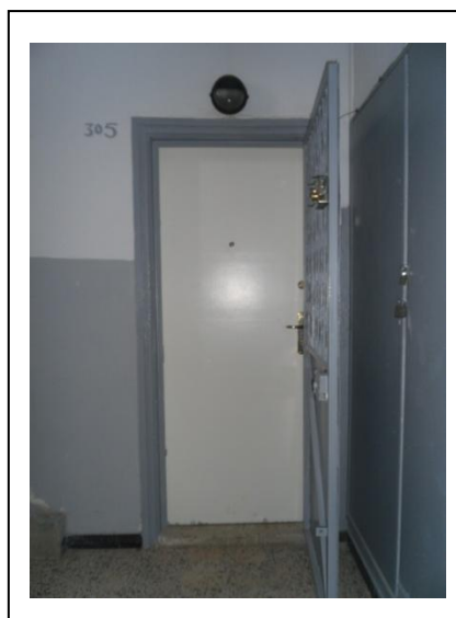
Photo 32: Renforcement de la porte d'entrée
