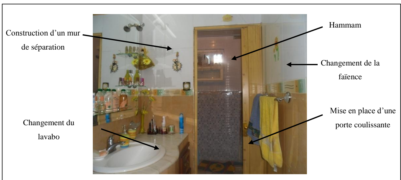
Photo 27: la SDB divisée en deux sous espaces
