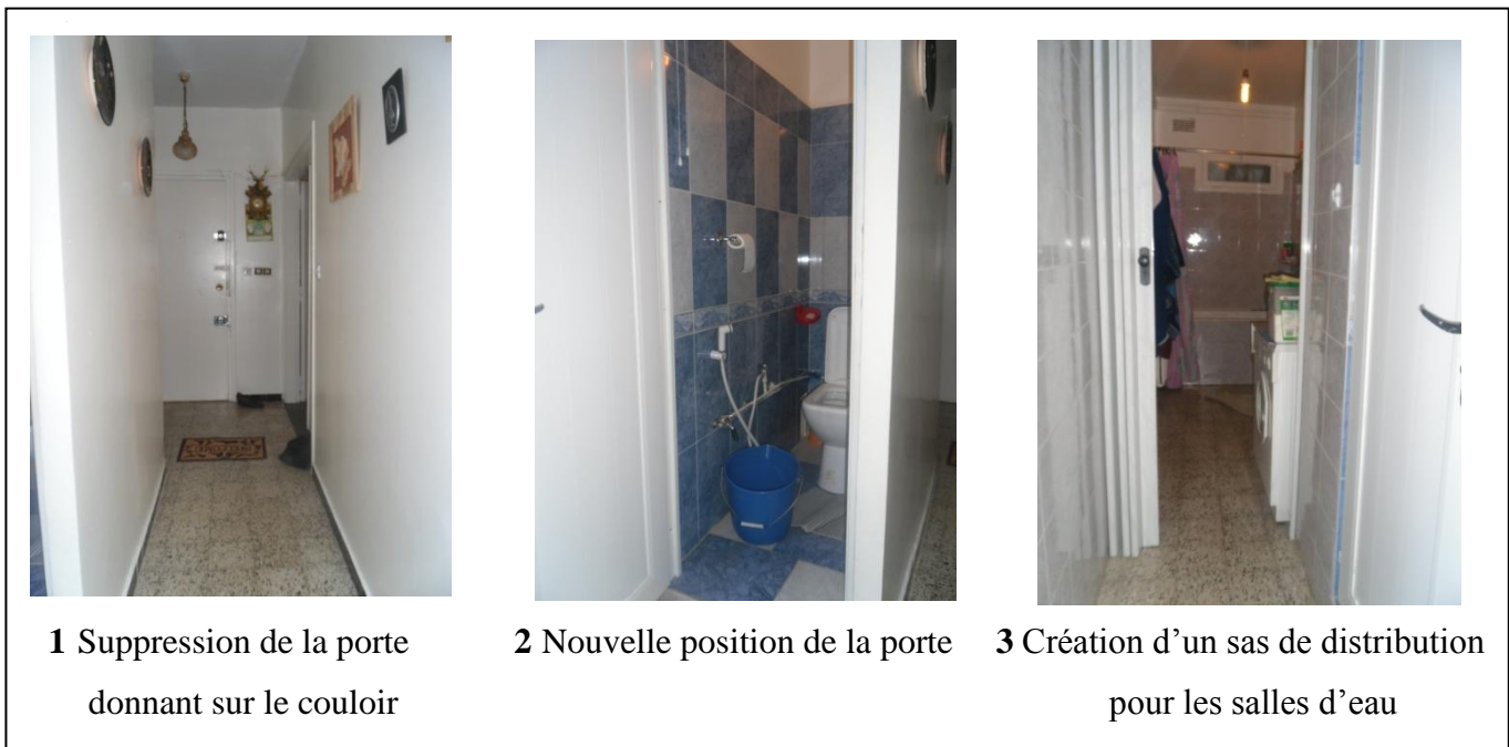
Photo 29 : Changement de la position des portes des salles d'eau Source : auteur (2011)
