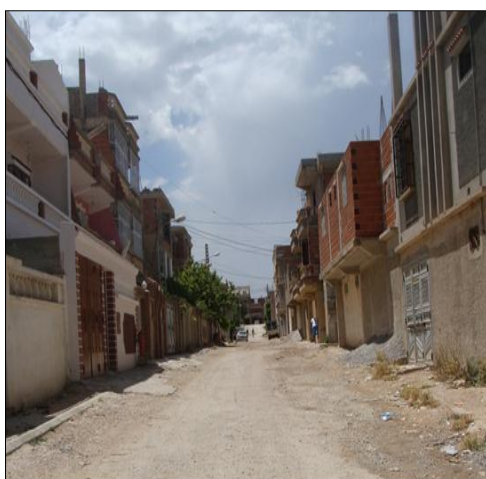
Cité 4 chemins: l'état dégradé des voiries
