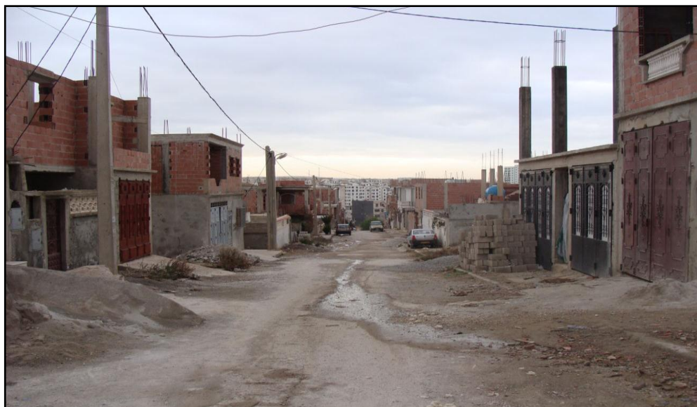
PHOTO 7: Etat des lieux, chantier éternel, mauvaise état des voiries. (150 logts, Ville Nouvelle)
