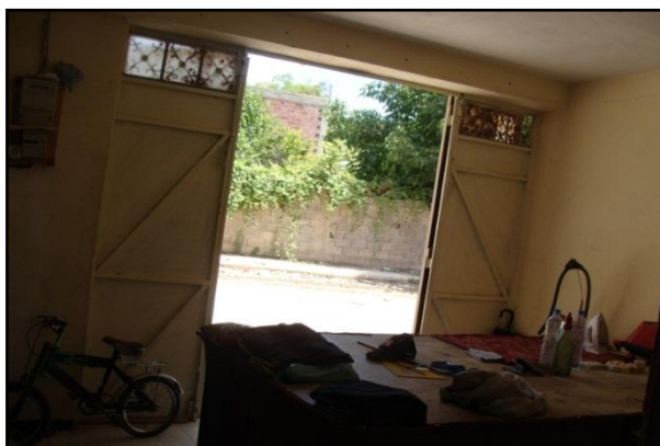
PHOTO 20 : Construction et aménagement d'un atelier
