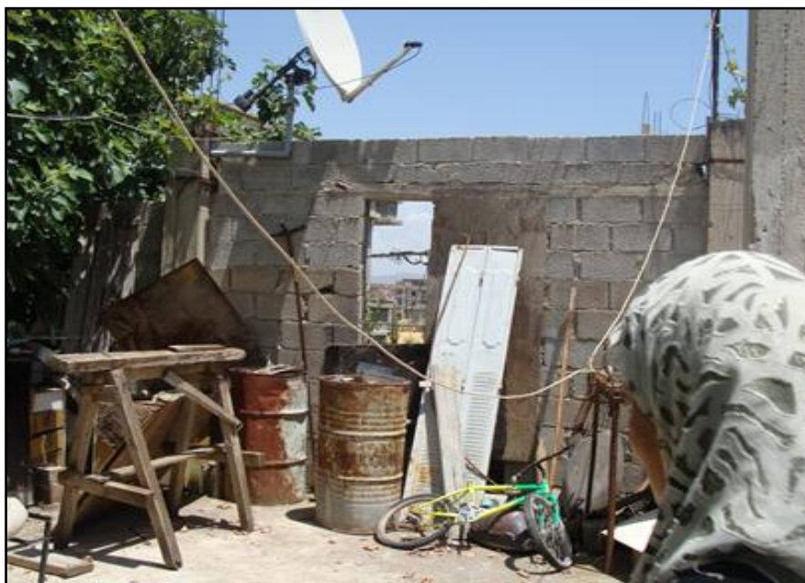
PHOTO 40: Installation des différents matériaux de construction à la terrasse.
