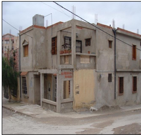
Cité 150 logts, Ville nouvelle
