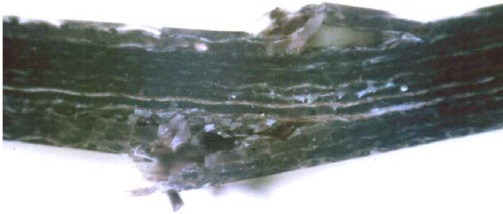
Fig. 4.42. Faciès de rupture après endommagement du stratifié [90_2/0_2/90_2/0_2]_S
