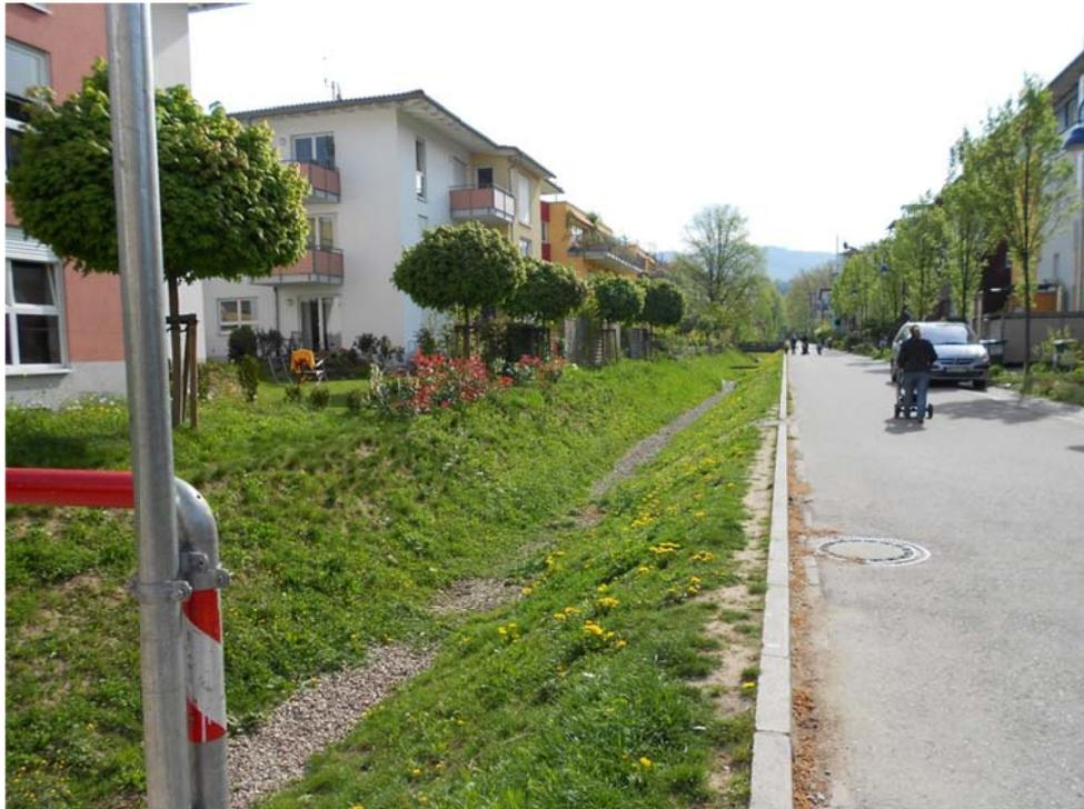
**Figure A12. Système de récupération d'eau des eaux pluviales. (Source auteur)**
