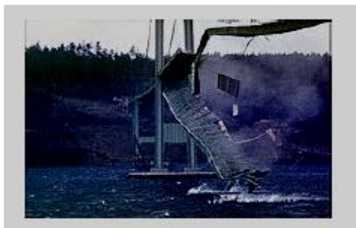
Figure II.4: Effondrement d'un pont auto-excité [3].
