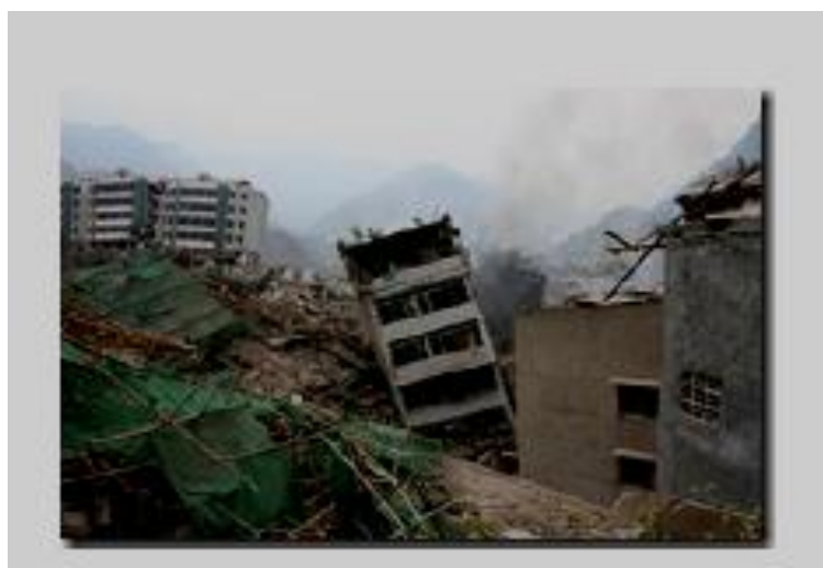
Figure II.3: Séisme à Wenchuan, Chine [3].
