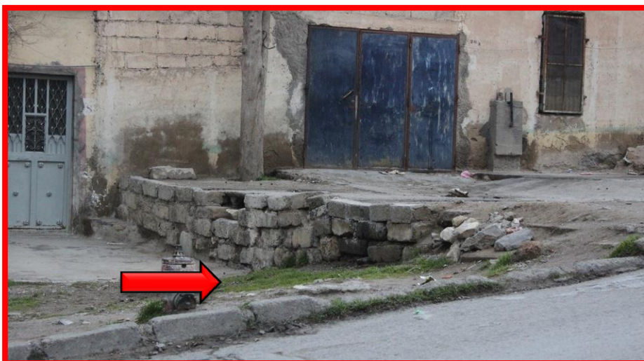
Figure 40 Exemple détérioration de la voie piétonne, Yahiaoui (source auteur)
