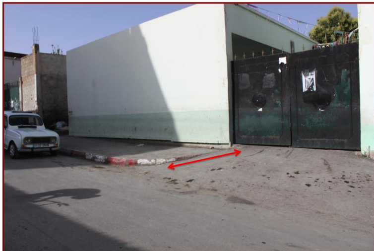
Figure 62 Accueil école Lamouchi (source auteur)
