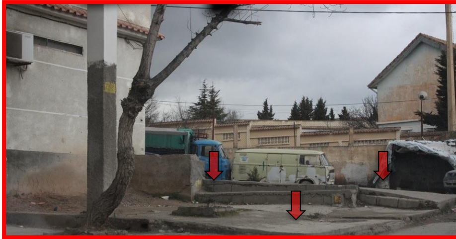
Figure 38 Exemple détérioration de la voie publique, Yahiaoui (source auteur)
