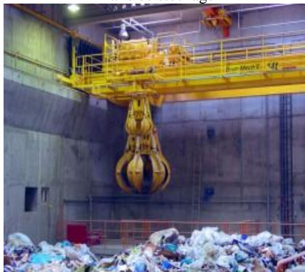
C- Pont roulant avec grappin et palan auxiliaire pour centrale d'incinération
