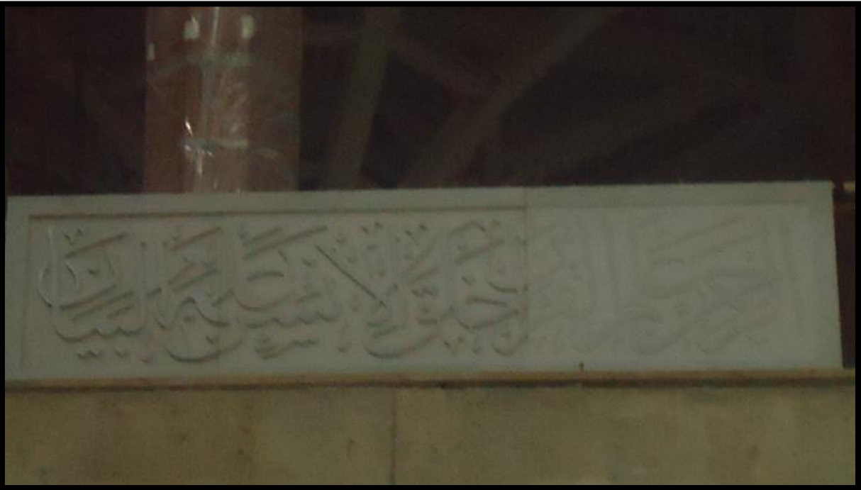
مشاهد عامة لجدار السدة (الطابق الأول) - المنحوت بحزام أفریزة الخط الفني - المصدر: الباحث (جويلية 2017)
