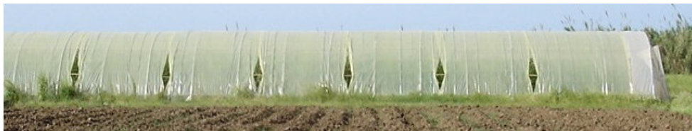
Figure 6 : Serre non chauffée de tomate mettant en évidence les ouvertures latérales obtenues par écartement des bâches pour l'aération passive.
