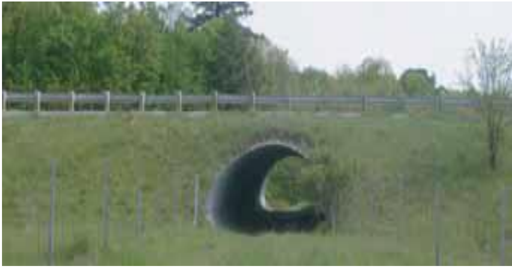
Fig. 48. Exemple d'un corridor sous terrain
