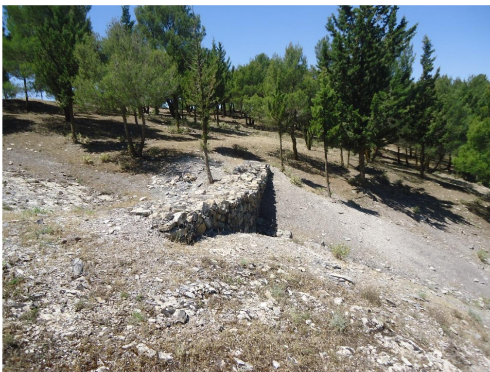
Fig. 30. Les corrections torrentielles photo 2014
