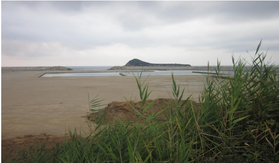
Figure : Construction d'un nouveau port de l'Aouana (Bounar, 2014)
