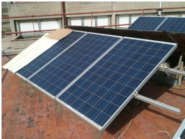
Figure III.3. GPV en cas d'ombrage partiel artificiel.
