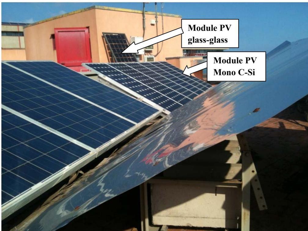
Figure A.1. Modules PVs installés sur le toit du bâtiment des laboratoires de DIEEI de l'université de Catane, Italie.
