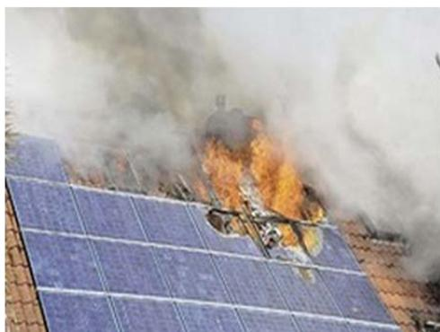
Figure.C.13. Incendie des modules PVs due à un câble mal connecté.
