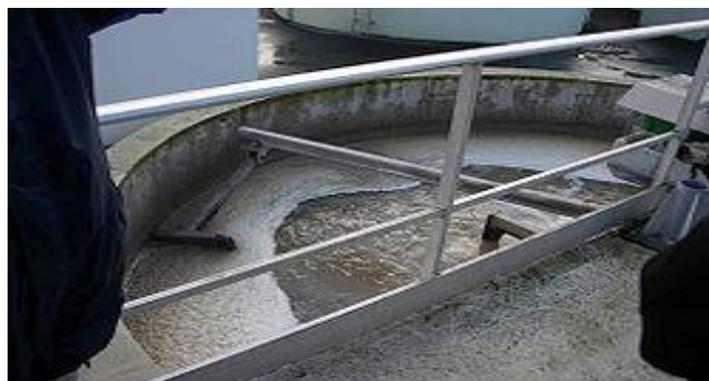
Figure 4 : Déshuilage par écumage des graisses, (Anonyme 2, 2006)
