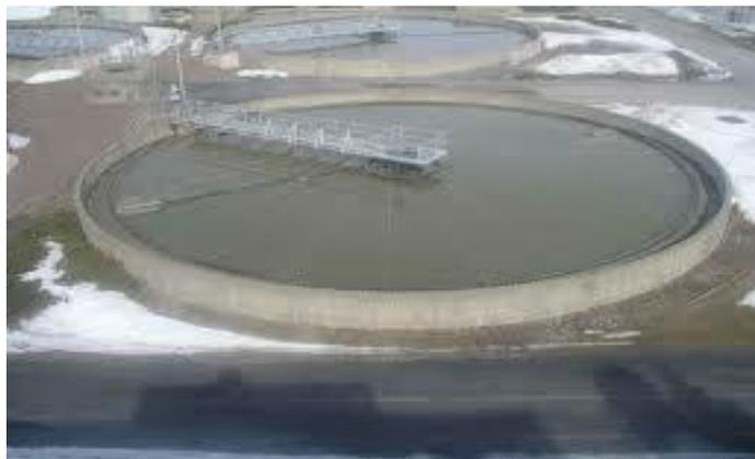
**Figure 5 : décanteurs primaires circulaires alimentés par le centre, (Anonyme 2, 2006)**
